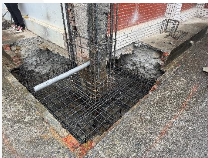
基礎鋼筋綁紮
