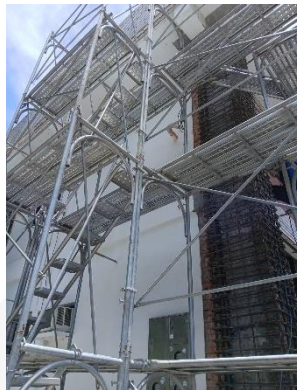
擴柱鋼筋綁紮
