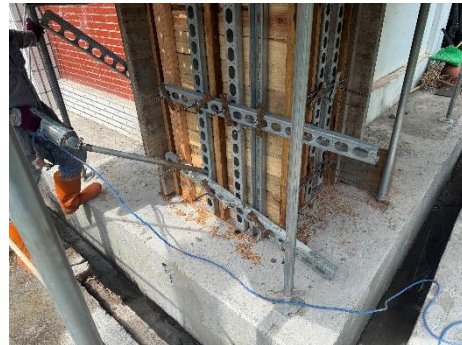
擴柱混凝土灌漿搗實
