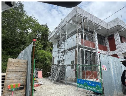
施工架搭設
