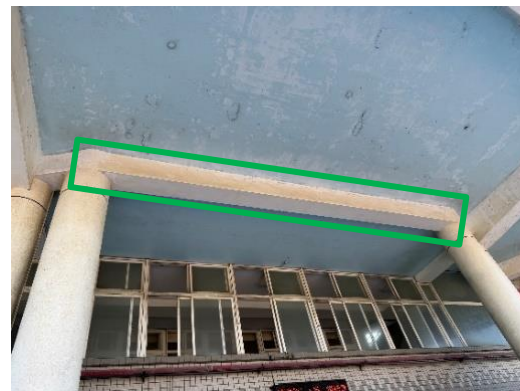
B棟碳纖維補強位置現況
