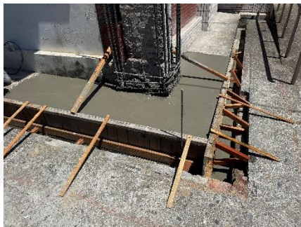
基礎混凝土澆置
