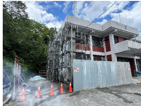
擴柱結構體完成面
